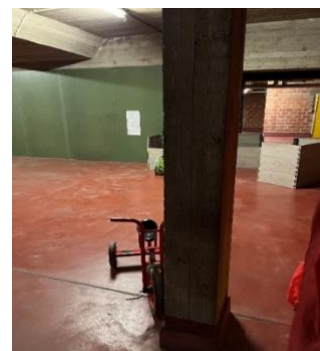
Vue du garage
